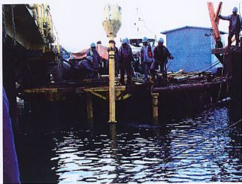
Tremonha posicionada para lançamento: equipamento exige concreto auto-adensável, com alta plasticidade
